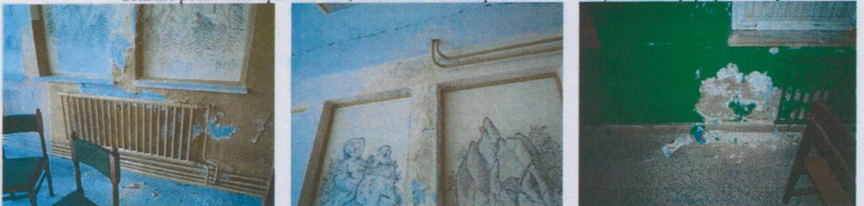
Lokálne navlhnuté a poškodené vnútorne omietky
