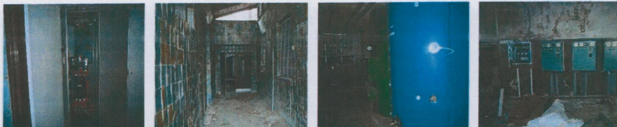
Vnútorne priestory objektu v 1.NP - hlavný rozvádzač, chodba medzi kotolňou a jedálňou, kotolňa s novým elektrickým kotlom ÚK a pôvodným nefunkčným vybavením
