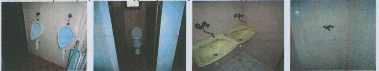
Vnútročné priestory objektu v 3.NP – typové vybavenie spoločných sociálnych zariadení
