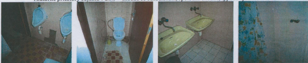
Vnútorne priestory objektu v 2.NP -typové vybavenie spoločných sociálnych zariadení
