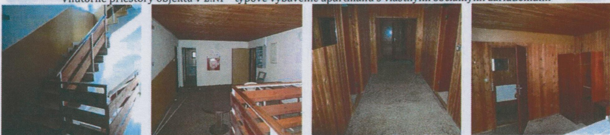
Vnútorne priestory objektu v 3.NP - chodba so schodiskom, spoločná chodba, typové vybavenie izieb
