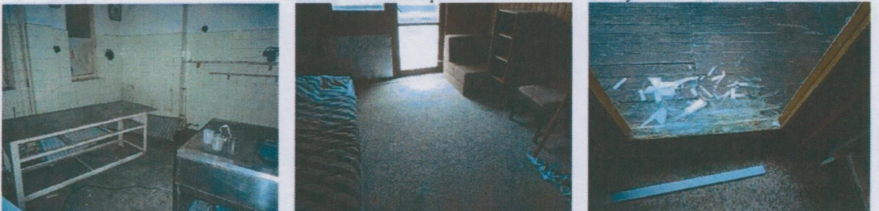
Demontované vybavenie kuchyne, vykurovacie telesá, poškodené výplne okenných otvorov
