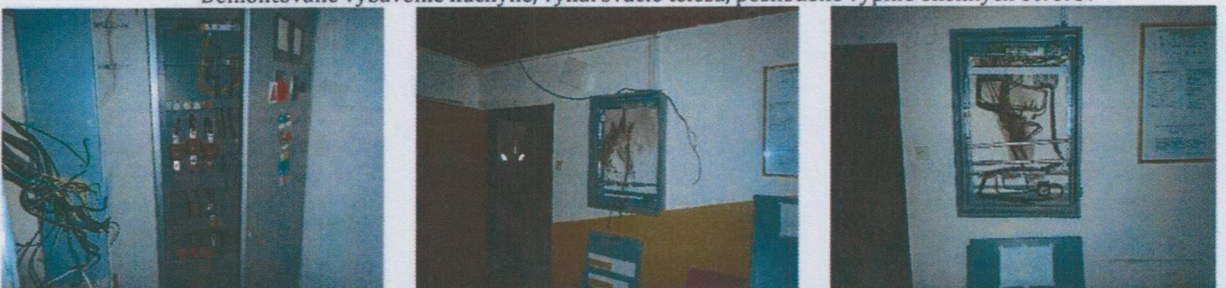
Poškodené rozvádzače na jednotlivých podlažiach
