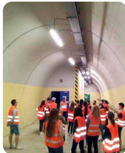
Exkurzia v tuneli Ovčiarsko
