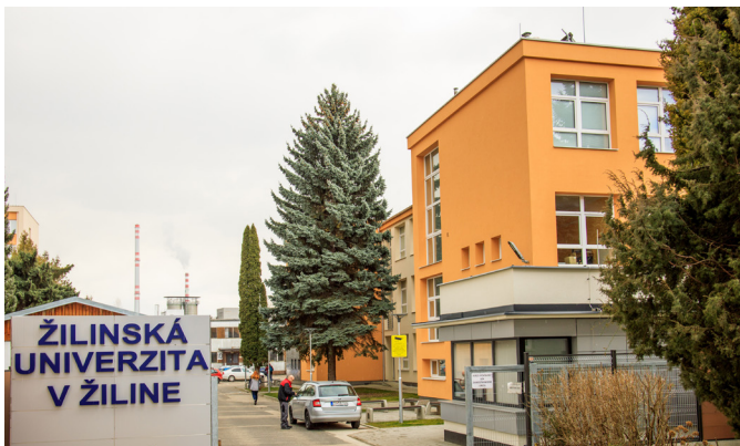
Pohľad na nový vstup na FBI
