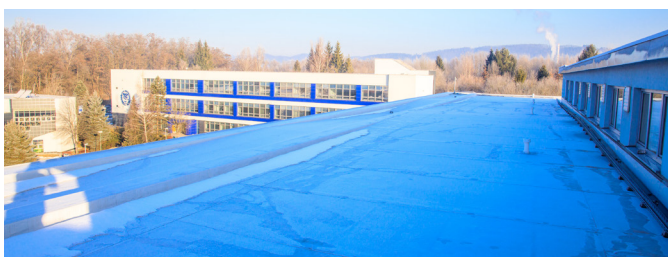
Sanácia strechy na hlavnom vstupe a pavilóne AF
