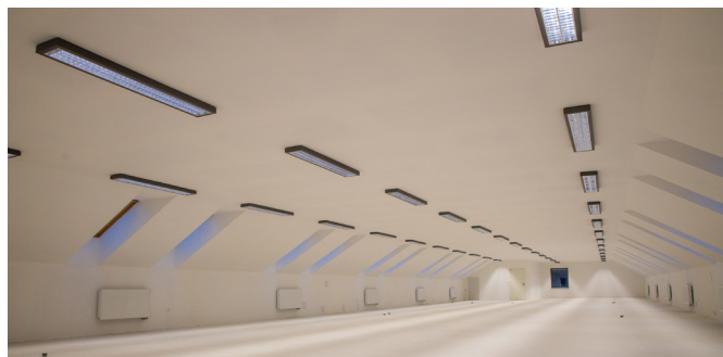
Pohľad do zrekonštruovanej budovy C na letisku v Dolnom Hričove
