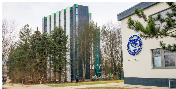
Pohľad na rekonštrukciu UZ VD, bloky DC, DD
