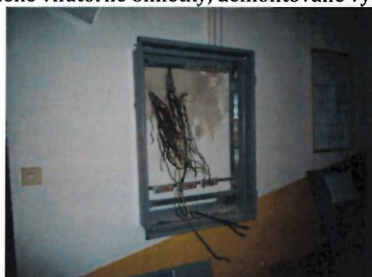
Poškodené rozvádzače na jednotlivých podlažiach
