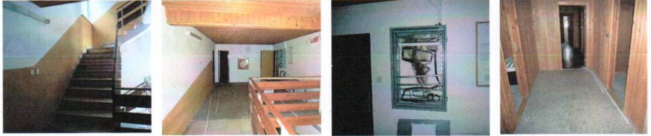
Vnútorne priestory objektu v 3.NP – chodba so schodiskom, poškodený rozvádzač, spoločná chodba
