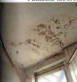
Navlhnuté omietky stropu hlavnej vrátnice, typové vybavenie kancelárie a spoločných sociálnych zariadení- prízemie (1.NP)
