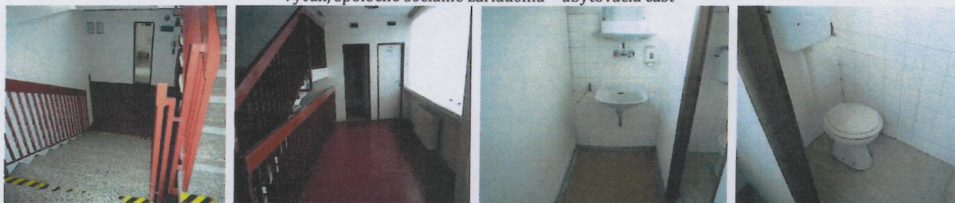
Hlavné schodisko s chodbou a spoločnými sociálnymi zariadeniami – ubytovacia časť
