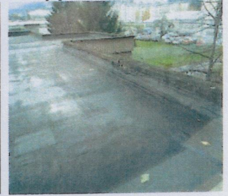
Prízemná časť objektu - spojovacia chodba s ubytovacou časťou, strecha nad prízemnou časťou s poškodenou atikou a oplechovaním, lokálne odlepenou krytinou
