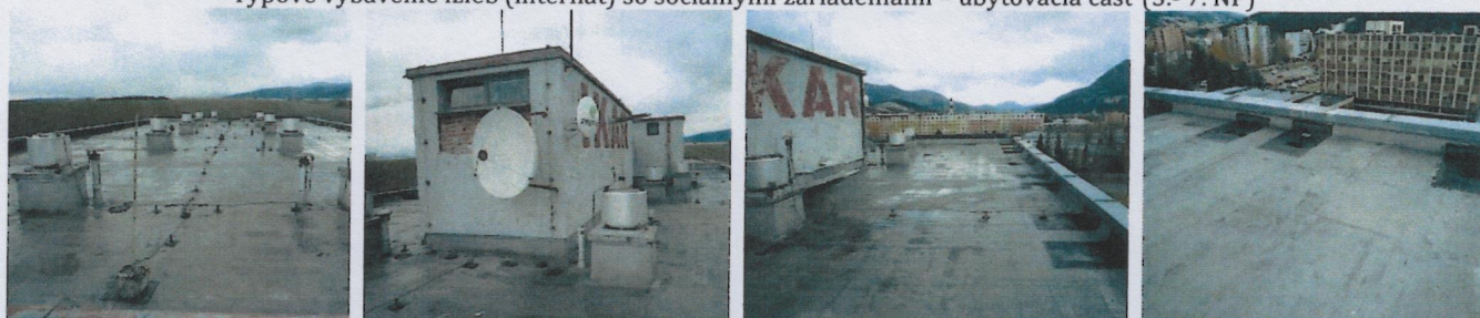
Pohľady na strechu objektu ubytovne č.s.1920, výťahová šachta, pohľady na lokálne opravy strešnej krytiny ubytovne
