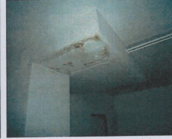
Spoločná chodba, učebňa s lokálne zatečenými omietkami v dôsledku porúch stúpacích rozvodov- ubytovacia časť
