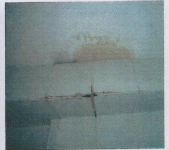
Prízemná časť objektu - hlavný vstup s vrátnicou, spoločenská miestnosť, lokálne navlhnuté omietky pod strechou
