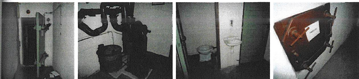
Vybavenie CO krytu, vstup do výlezu- suterén (1.PP)
