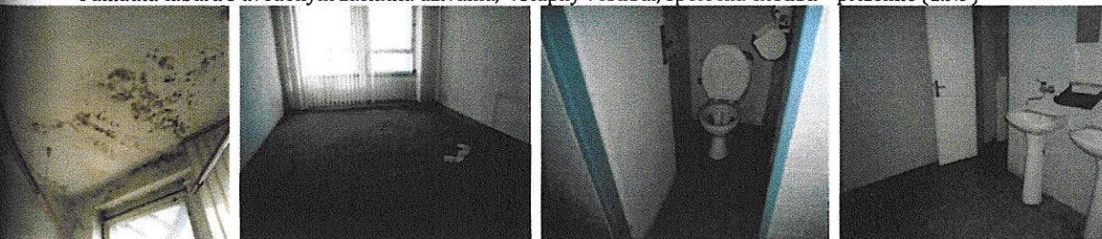
navlhnuté omietky stropu hlavnej vrátnice, typové vybavenie kancelárii a spoločných sociálnych zariadení- prízemie (1.NP)
