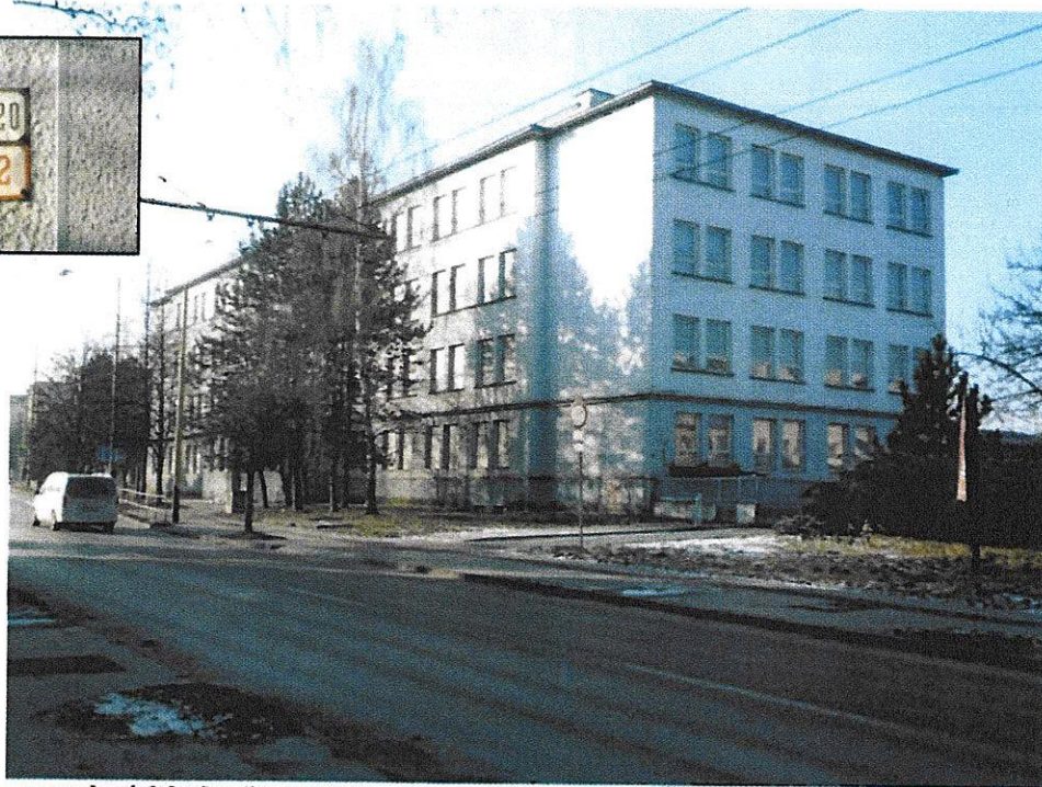
Škola - stavebná fakulta č.s. 2620 na parc.č.4451/60, k.ú. Žilina - SV pohľad z ul. Komenského
