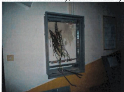
Poškodené rozvádzače na jednotlivých podlažiach
