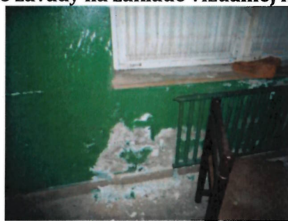
Lokálne navlhnuté a poškodené vnútorne omietky, demontované vybavenie kuchyne, vykurovacie telesá
