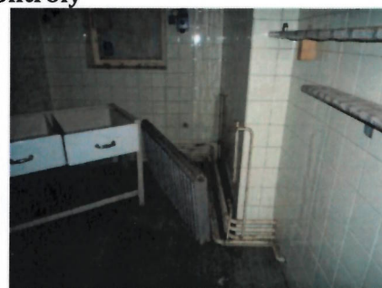
Lokálne navlhnuté a poškodené vnútorne omietky, demontované vybavenie kuchyne, vykurovacie telesá
